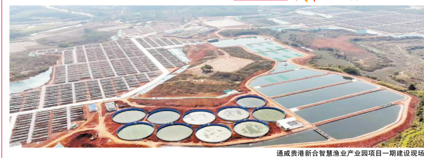
通威贵港新合智慧渔业产业园项目一期建设现场
